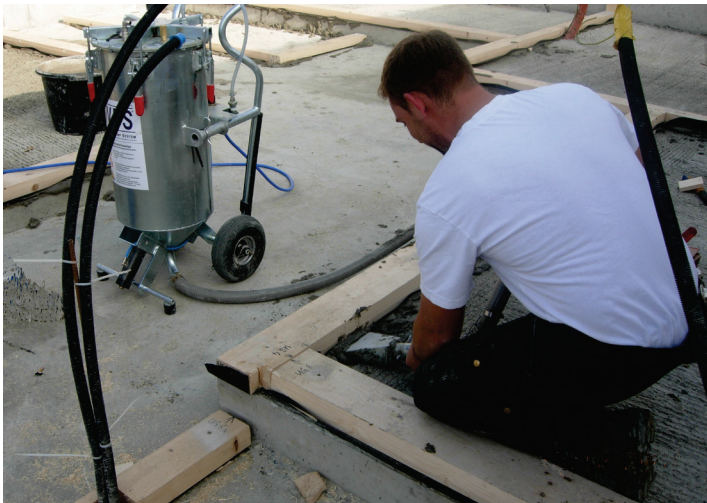
Untermörteln Holzschwellen
