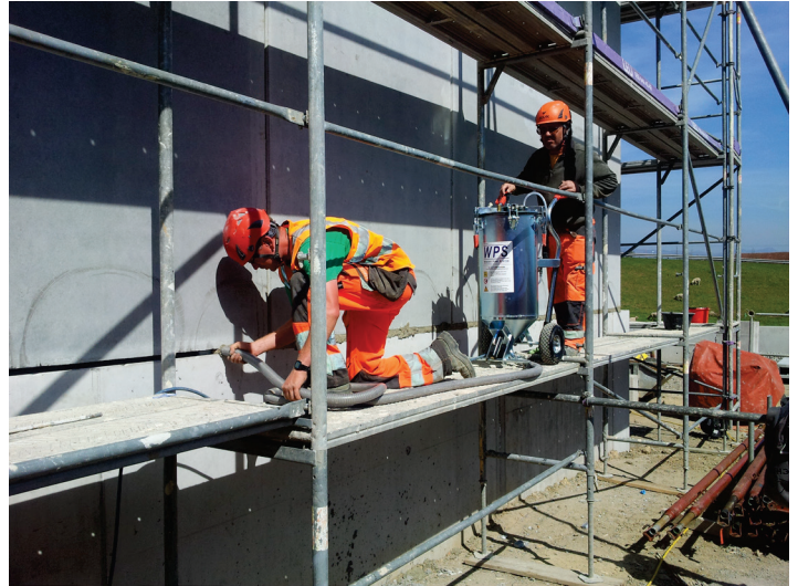
Untermörteln Betonelemente
