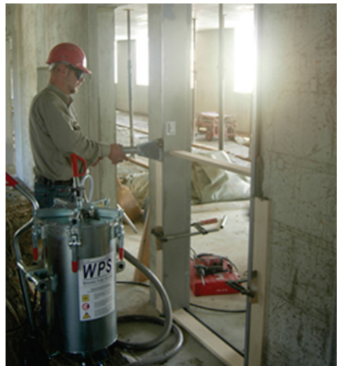
Ausmörteln Stahlzargen
