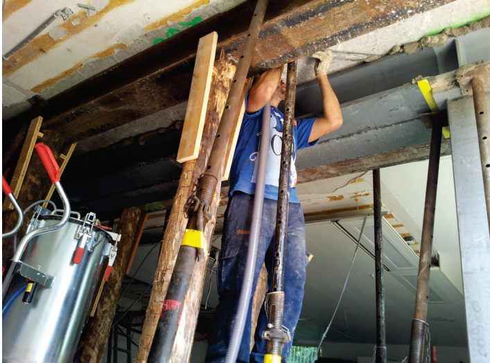
Untermörteln Stahlträger
